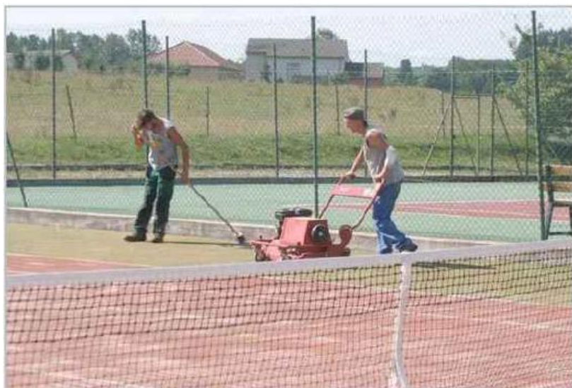
L'entreprise Gotec, d'outre-Rhin, a procédé au nettoyage de la moquette du court de tennis n° 1.
