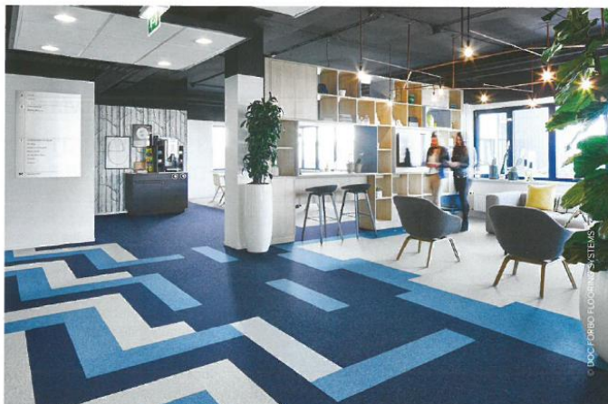
◀ LA RÉVISION DU NF DTU 53.1 PREND EN COMPTE LES NOUVEAUX FORMATS EN LAMES DES DALLES TEXTILES PLOMBANTES.
